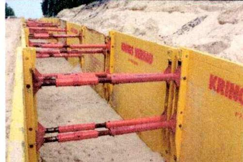
Fig. 7 Entibado con apuntalamiento hidráulico
